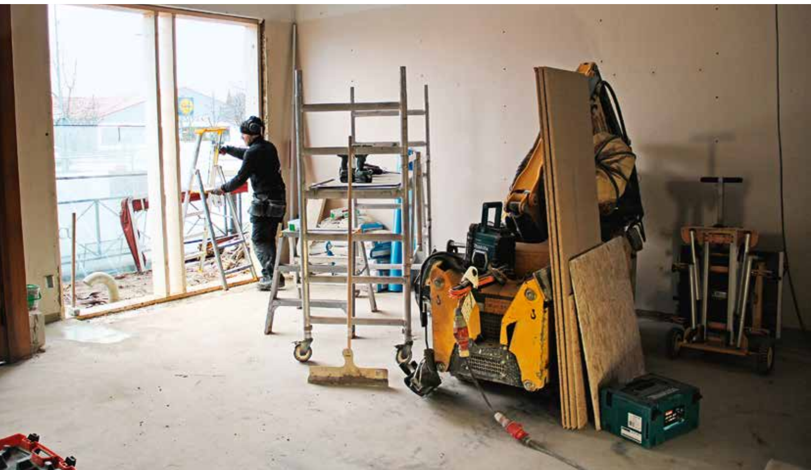
Ombyggnationen på Parkgatan och Nämndemansgatan har genererat 11 nya lägenheter.
